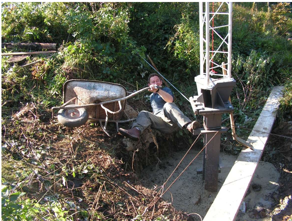
Prace przy stabilizacji masztu na Kopie Biskupiej
